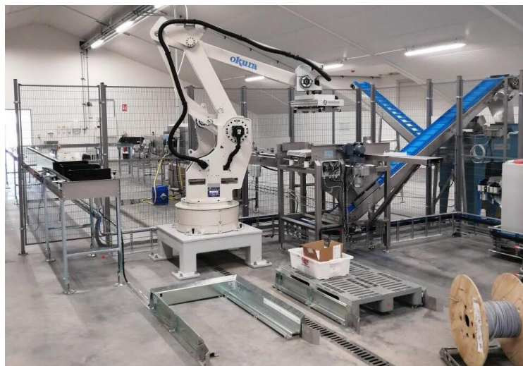
Installation af robotarm i POC stalde.
